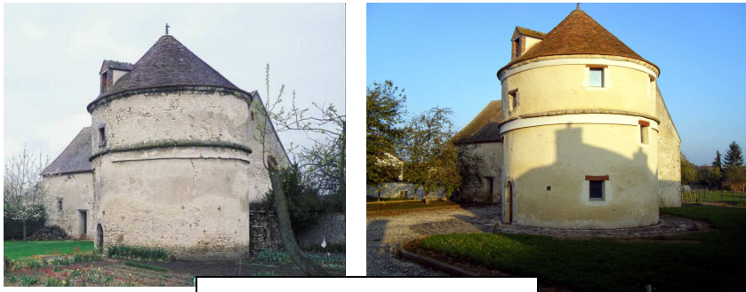
Avant et après rénovation
